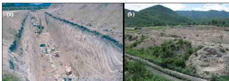
Figura 1. a) La trinchera de 1.500m 3 (5m x 5m x 60m) fue excavado con una excavadora (138 hp, cucharón de 1 m 3 ) en 36 horas y durará 3 o 4 semanas antes de llenarla. El metano está controlado con chimeneas de piedra utilizando de método de Jaramillo [4]. b) El suelo excedente de las excavaciones está almacenado para ser utilizado después en el relleno, o en otros lugares fuera del sitio, lo que se llama valorización
