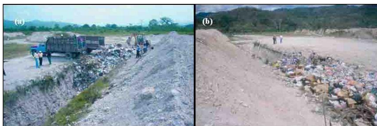
Figura 2. a) Se descargan los desechos en la trinchera formando la celda diaria, lo que tiene el mínimo de área superficial expuesta. Se nota el suelo excedente de la excavación al lado derecho. b) El área superficial expuesta de la trinchera es mínimo durante el llenado longitudinal con celdas diarias
