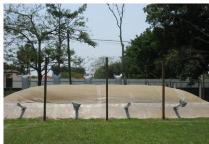
Figura 1. Características del biodigestor tipo cúpula
