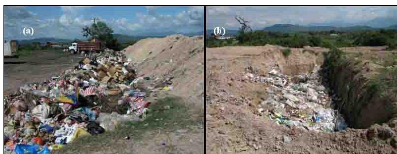
Figura 3. a) Se deja la trinchera llena sin cobertura durante 3 o 4 semanas para permitir la compactación natural por biodegradación semi-aeróbica y el asentimiento por el peso de los desechos. b) Una trinchera llena después de 3 semanas de compactación natural, obtuvo una ganancia del 30-40% del volumen original
