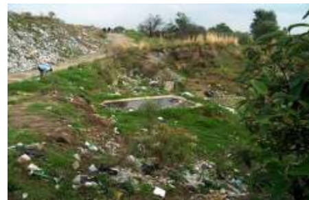
Figura 5. Cárcamo de lixiviados en el sitio para RSU de Rayón.
