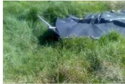
Figura 3. Cárcamo de lixiviados de “El Socavón”.
