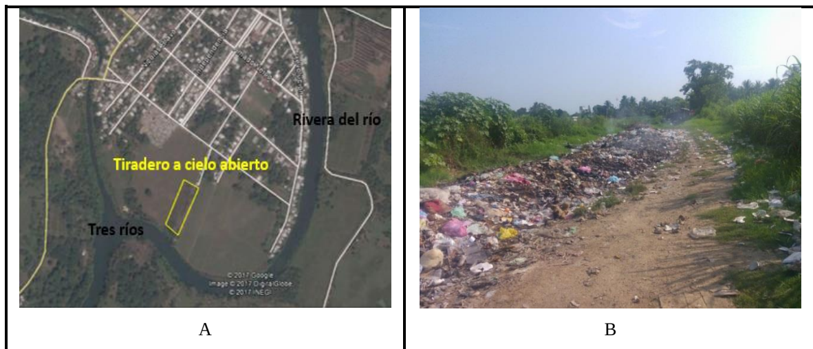
Figura 6. Tiradero a cielo abierto de Acuña, Veracruz, México. Vista aérea y terrestre
