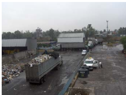
Figura 14. Planta de separación y estación de transferencia de Aragón.
